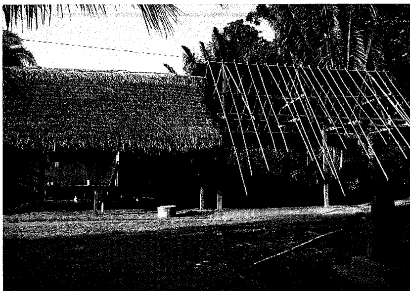
Vivienda en construcción. Comunidad Anexa Cucuasa - Río Santiago. Perú
